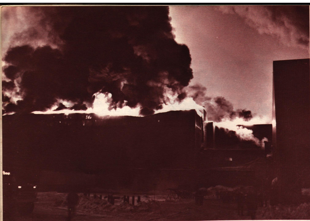
Un violent incendie qui a éclaté en février dernier durant un arrêt normal des opérations de la Mine Scully pour des vérifications routinières, a tenu les pompiers de Wabush et de Labrador City en alerte pendant plus de cinq heures. Les dommages se sont chiffrés à plus de $5,000,000.00.
