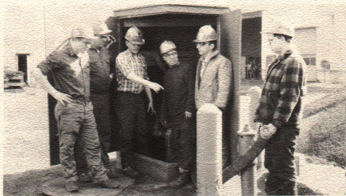
Checking a Fire Hydrant and a Hose Box. Vérification d'une borne-fontaine et de la réserve de boyau d'arrosage. Cyril Squires, Roy Maddox, Mike Timmins, Steve Rodgers, John Kelly, Dan Craig.
